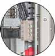
Low voltage fan input terminals
